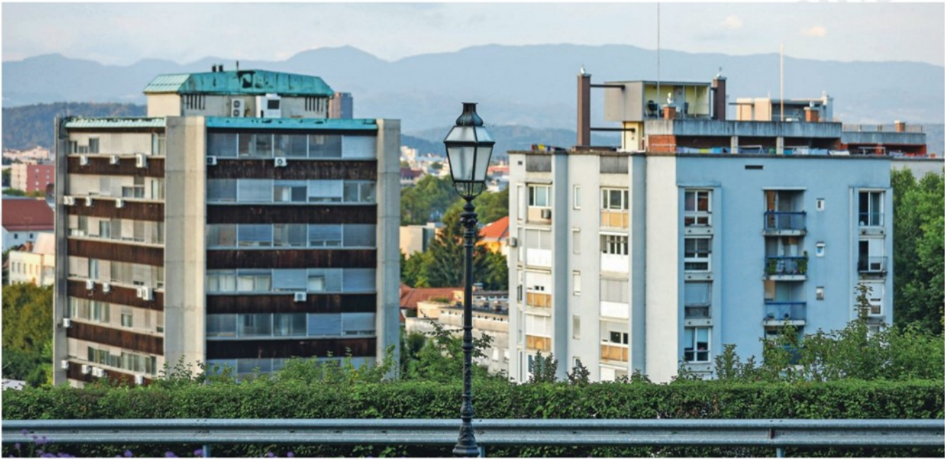
Z januarja izdanimi gradbenimi dovoljenji za stavbe je predvidena gradnja skoraj 850 stanovanj. FOTO JOŽE SUHADOLNIK
